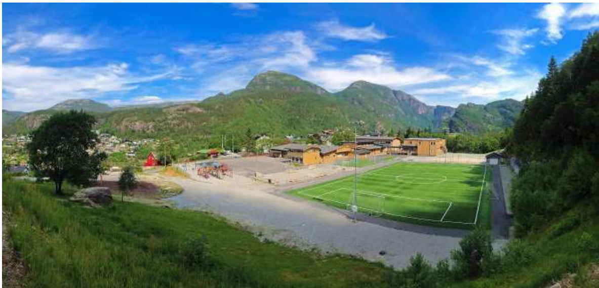
Figur 6-5 FB5 Stanghelle skule, idrettsanlegg og flaggplassen. Foto: Jan Adriansen, Sweco.
