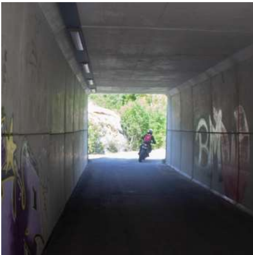
Foto 6-3 Undergangen under E16 i FB4 Hellevegen nyttast også av motoriserte køyretøy og kan vere skremmande for gåande. Foto: Jan Adriansen, Sweco.
