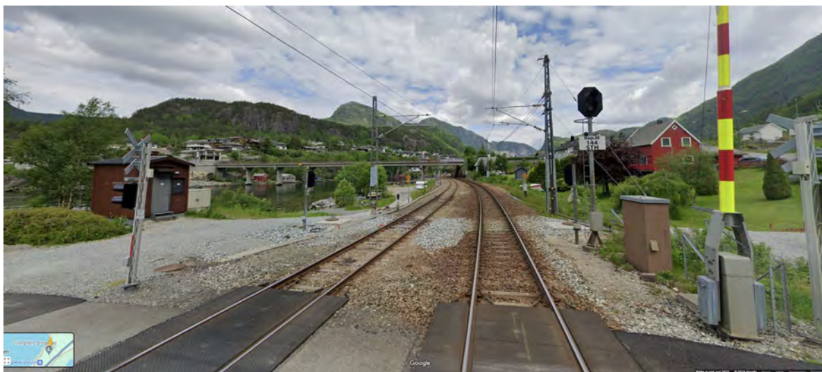
Figur 7 Dagens situasjon frå plankryssinga, Google streetview 2022
