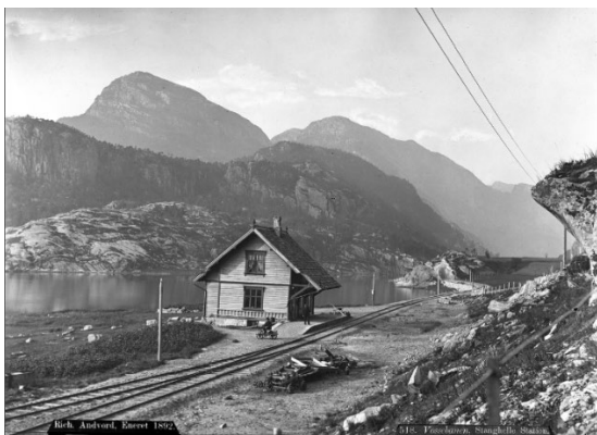
Fig. 6-3 . Stasjonsbygget Anno1892 (Kjelde: Fylkesarkivet)
