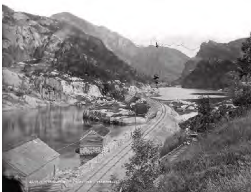
Figur 6-24. Historisk foto. Utfyllinga til jernbanen har gjort at gardshusa har blitt avskorne frå strandsone.. (Kjelde: Fylkesarkivet)
