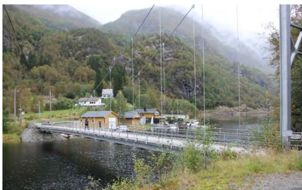
Figur 6-47. Hellestraumen bru som er frå 1927 og verna i kommuneplanen. (Kjelde: Henning Larsen)
