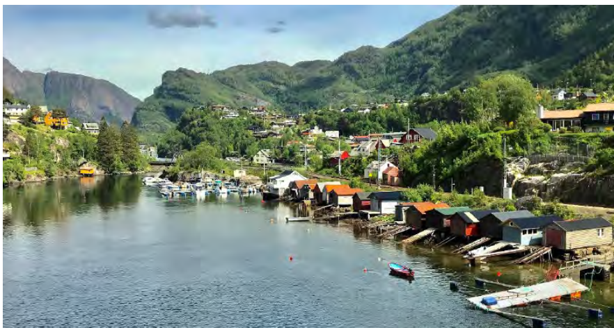
Figur 6-26. Naustrekja på austsida av Dalevågen (Kjelde: Foto: Tine Eikehaug, Statens vegvesen)
